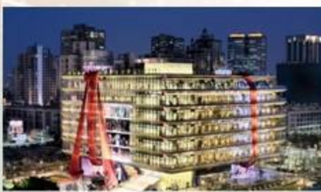
高雄市立圖書館總館新建工程
