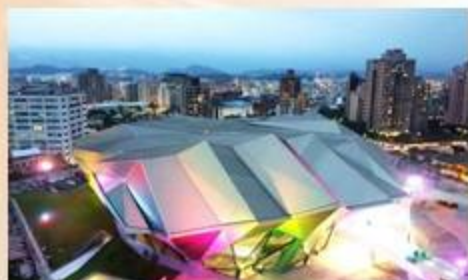
北部流行音樂中心興建工程(北基地)
