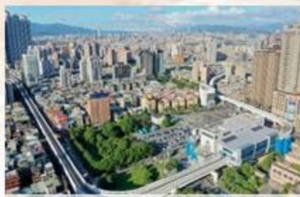
捷運環狀線CF660A區段標工程
